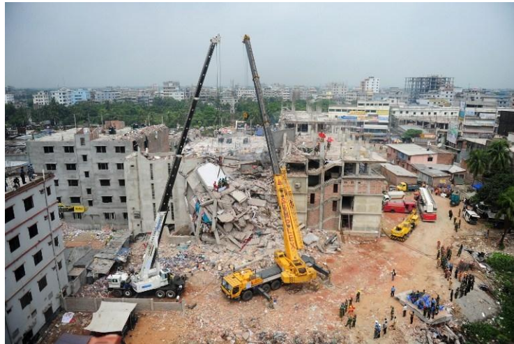
Figura 5 – Desmoronamento de prédio de nove andares de confecções em Bangladesh ( em 24 de abril de 2013 – 1.127 vítimas fatais)
